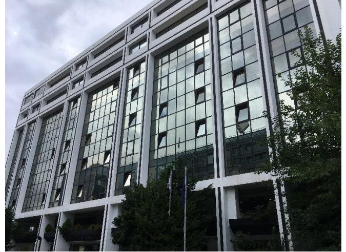
Εξωτερική όψη ακινήτου
