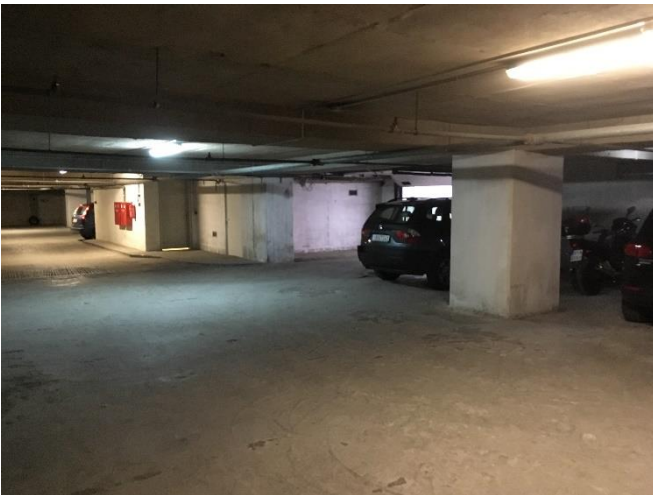
Θέσεις στάθμευσης υπογείου
